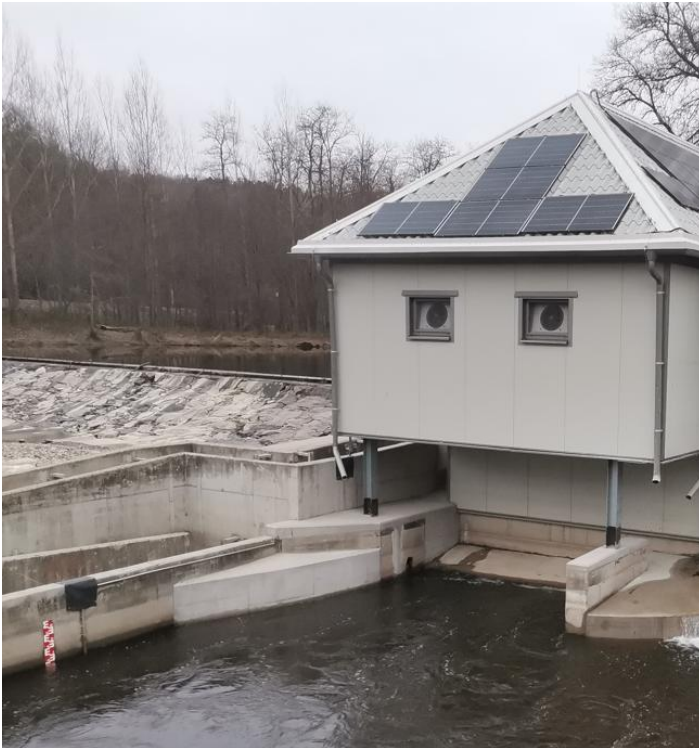
Kleinwasserkraftwerk Schönberg am Kamp
