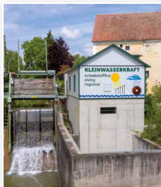
Beim Kraftwerk von Werner Wagner wird prominent auf den Wasserkreislauf und den dessen Relevanz für die Wasserkraft hingewiesen.
