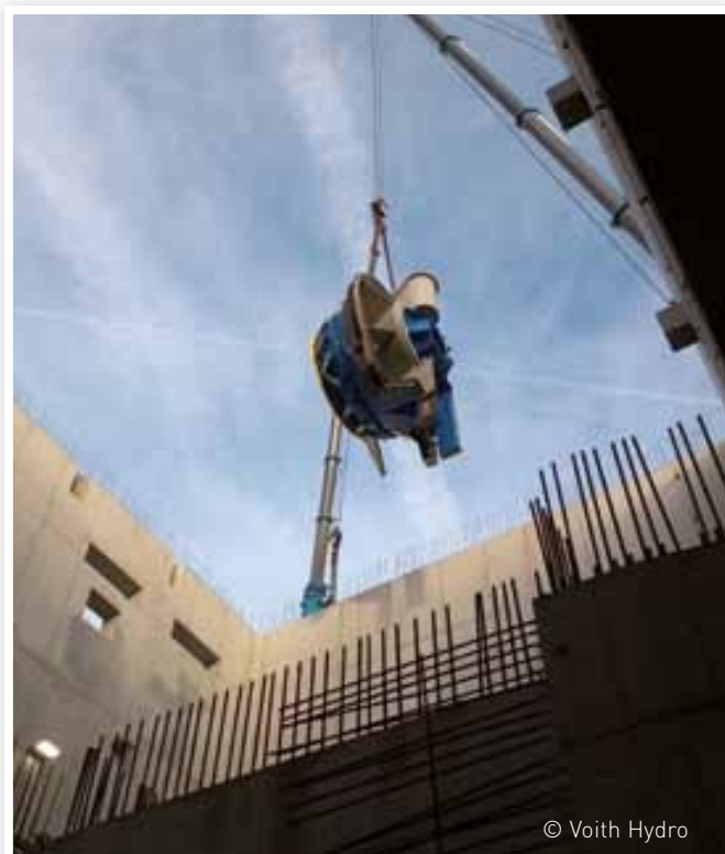
Stützschaufelring beim Einheben ins Kraftwerk
